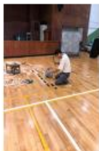
力行館地板維修
